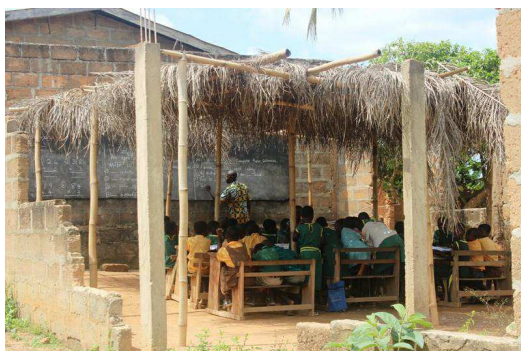
Das neue Großprojekt: Renovierung der Nsaba Zion School
