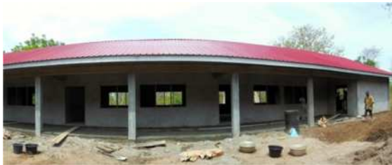
Die fertige Schule!
